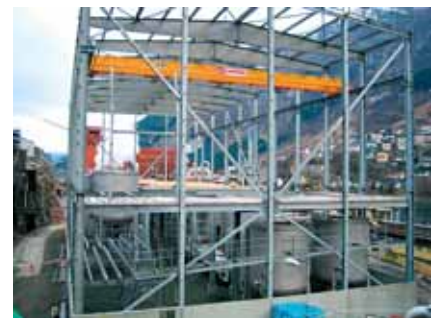
Keskiptiteräksiä teollisuusrakennuksessa.
