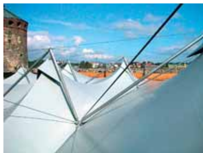
Kuumasinkittyjä kattorakenteita kulttuurirakennuksessa.
